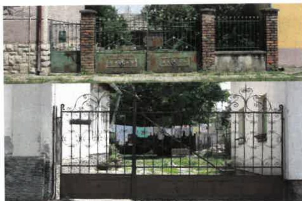
A Temető u. 19. és a Petőfi S. u. 18. szám alatti kerítések
